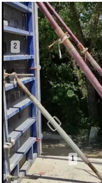
3-сурет. Қалқан пішінді қалыптарды тіректер арқылы деңгей бойынша орналастыру 1-тіректер, 2-қалқан пішінді қалып
