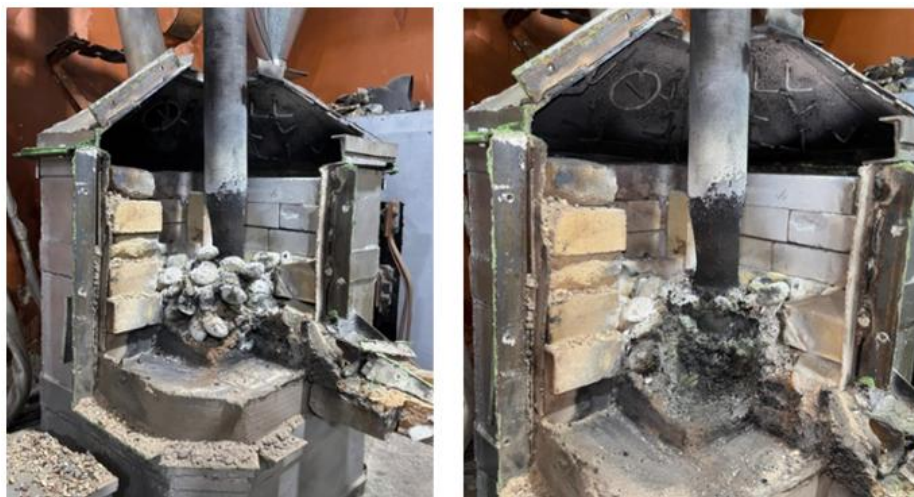
Рисунок 13. Вид демонтированной печи после синтеза
