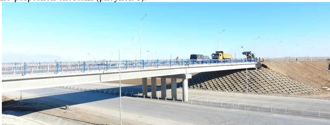
Рисунок 1 – Общий вид путепровода, габарит путепровода \Gamma - 10+2 \times 0,75 м, габарит по высоте – 5,5 м, схема путепровода – 2 \times 33,0 м, полная длина – 66,75 м, длина переходных плит – 8,0 м.
